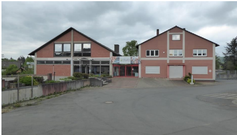
Foto 1 Eingangsbereich des ehemaligen Baustoffhandels „Knothe“
