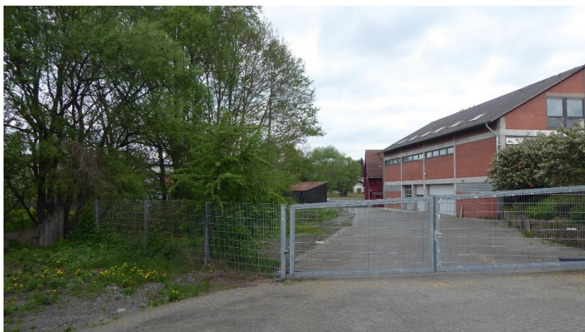
Foto 3 Ehemalige Ausfahrt zwischen Elmbach und Verkaufsbauwerk. Hier ist noch ein Rest des Gehölzbestandes entlang des Elmbaches verblieben.
